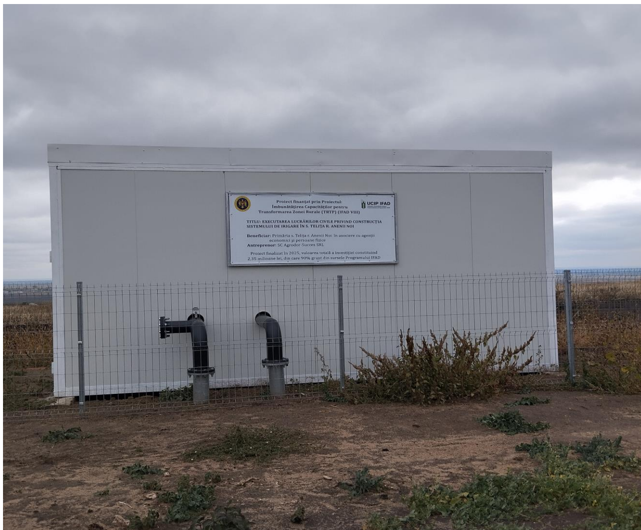
Foto.1: construcția sistemului de irigare din satul Telița din raionul Anenii Noi.
