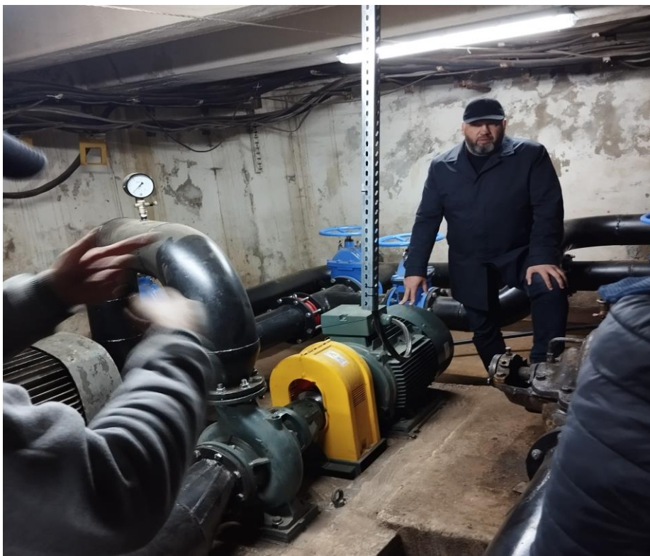
Foto.5: Reabilitarea stației de pompare prin procurarea și montarea unei noi pompe de apă pentru irigare, satul Varnița din raionul Anenii Noi
