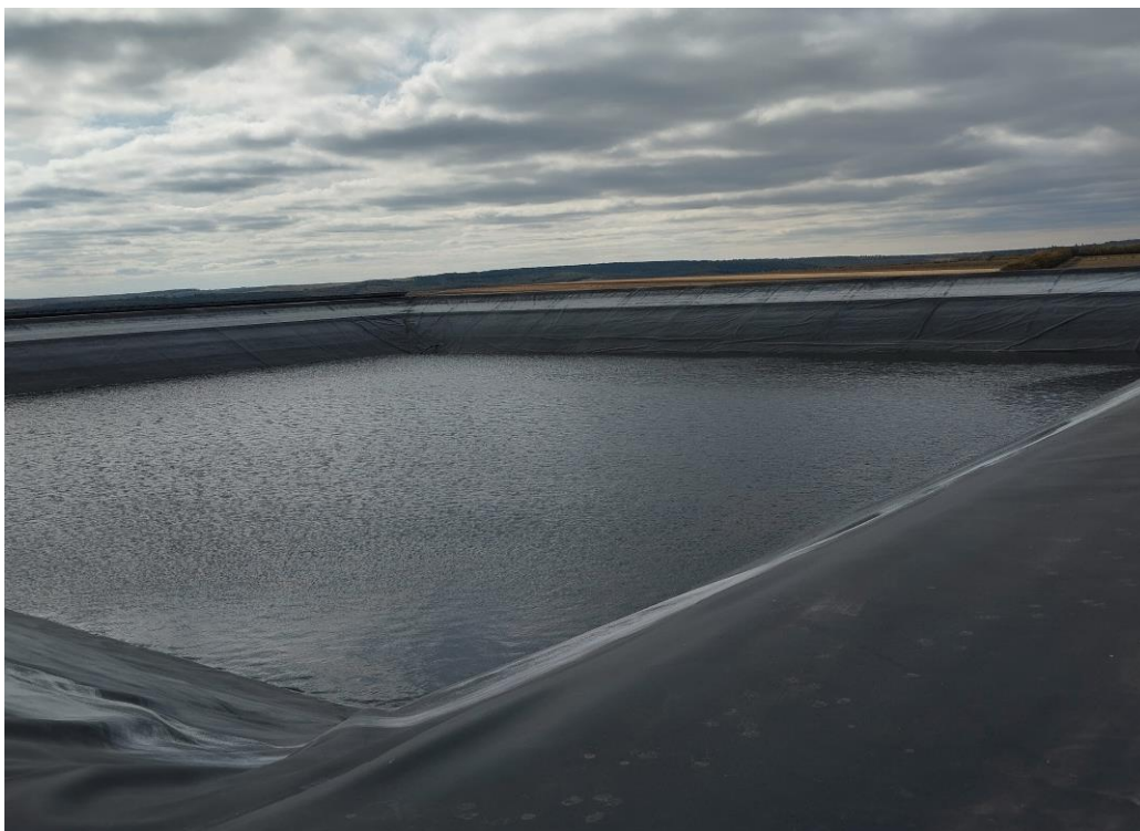
Foto.6: Construcția bazinului de acumulare a apei pentru irigare cu volumul 47000 m 3 , din satul Căinari din raionul Căușeni
