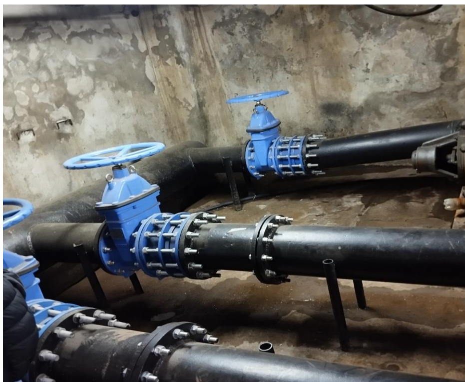
Foto.4: Reabilitarea stației de pompare prin procurarea și montarea unei noi pompe de apă pentru irigare, satul Varnița din raionul Anenii Noi
