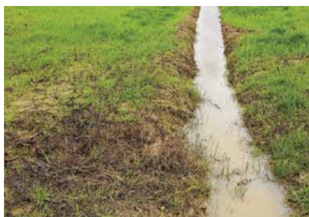
Fig. 76. Întreținerea unui sistem de șanțuri nesistematice de scurgere a apelor de suprafață
